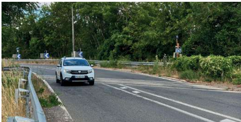
Passage à niveau après Gages
