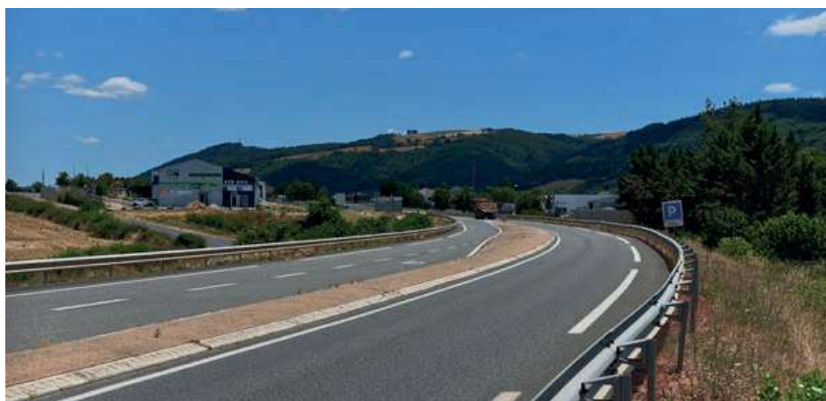
État actuel de la déviation de Recoules
