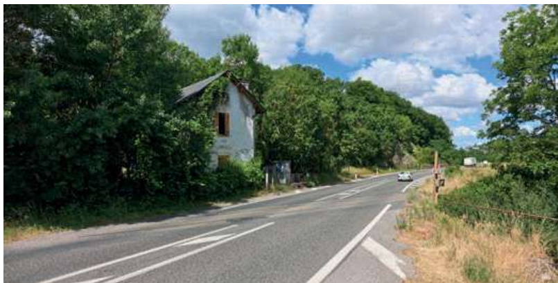
Passage à niveau après Bertholène
