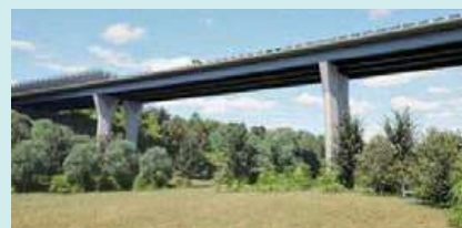
Vue de viaduc à piles hautes
