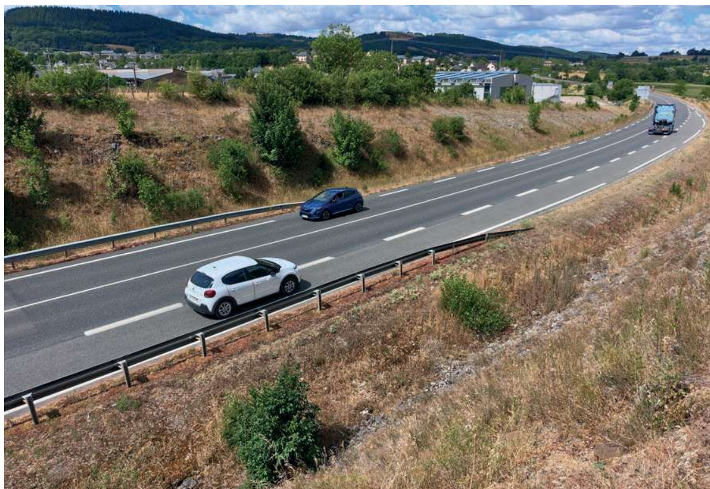
Photographie de l'échangeur existant de Laissac sur la RN 88
