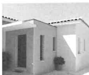
Exemples de traitement de façades
