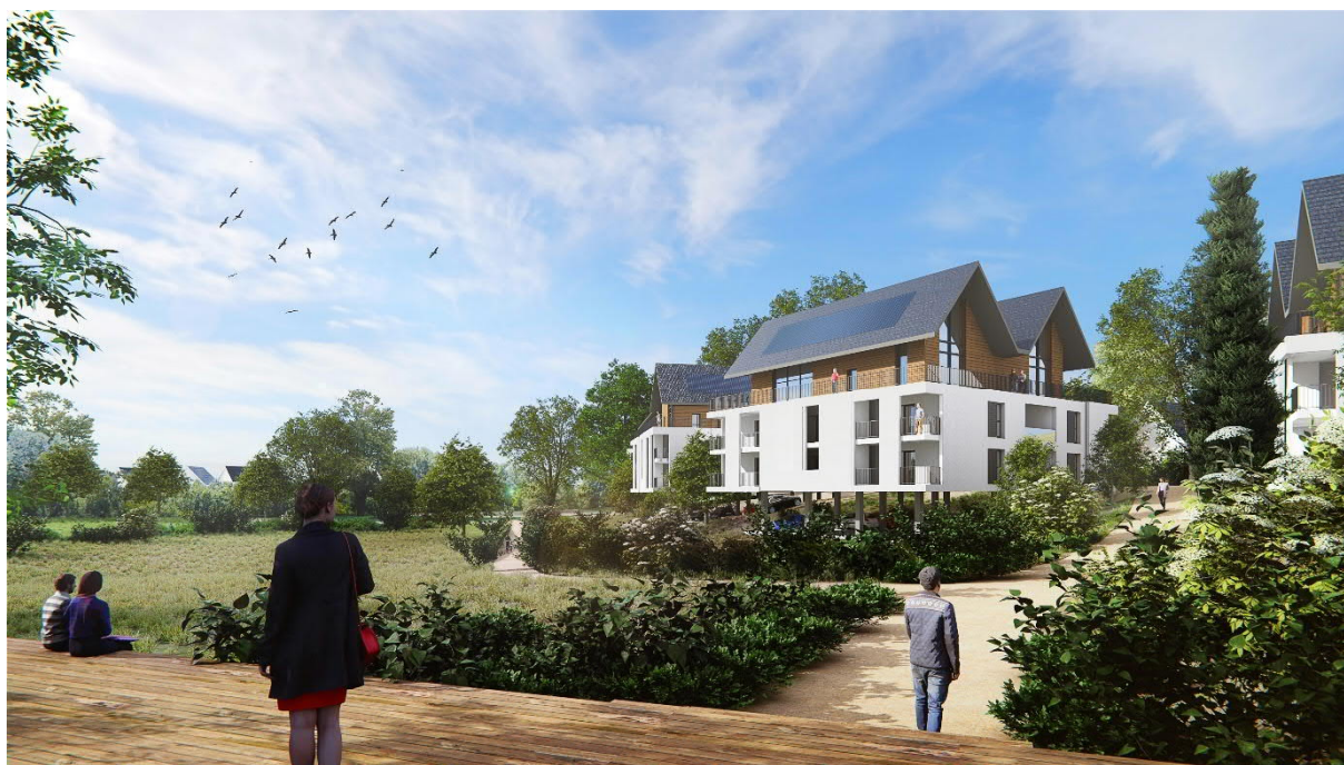
Les Logements collectifs en bordure du parc
